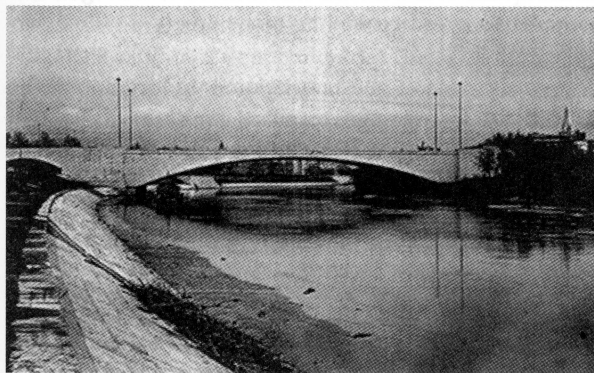
Fig. 2. Il ponte Duca d'Aosta sul Tevere è ad arco parabolico; è stato costruito nel 1939
